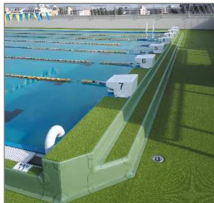
改修後の学校施設
