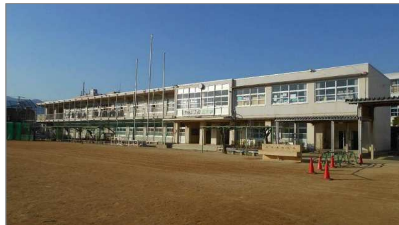
瓦木中学校現況
