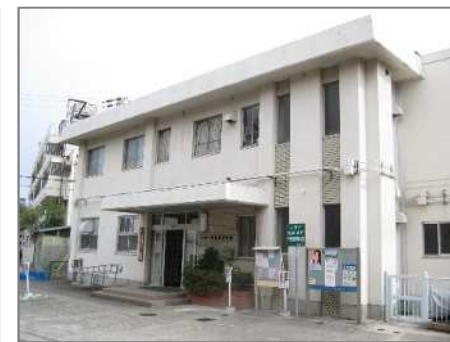
甲陽園市民館現況
