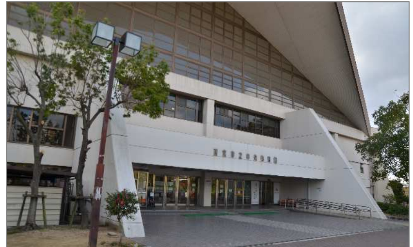
中央体育館現況
