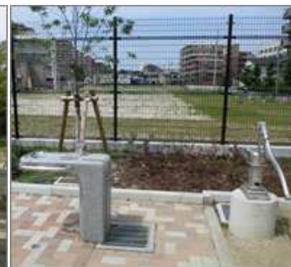
水飲み場と手押しポンプ
