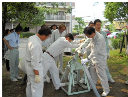
緊急貯水槽の操作訓練（津門中央公園）
