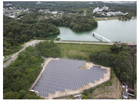
北山配水所太陽光発電設備
