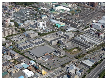
阪神水道企業団 尼崎浄水場（尼崎市）
