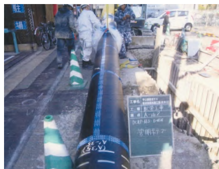
配水管布設工事（甲東園1丁目）
