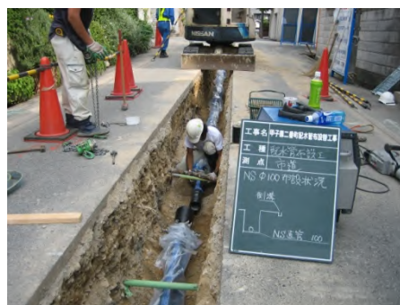
耐震管への布設替工事（甲子園二番町）
